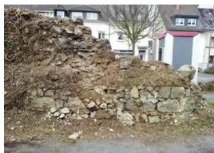
Ein Bauwerk aus dem 14. Jahrhundert! Stadtmauerrest am
