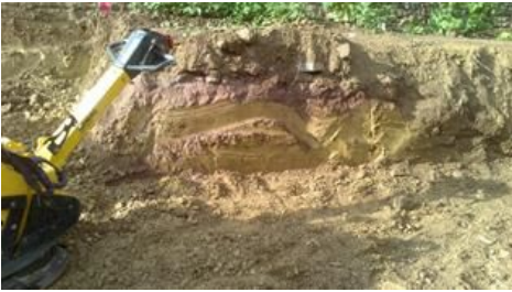
Abb. 2: roter und gelber Ton in der Baugrube
