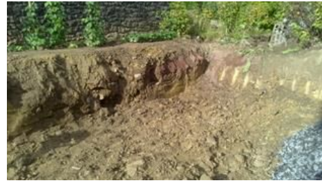
Abb. 3: roter und gelber Ton in der Baugrube
